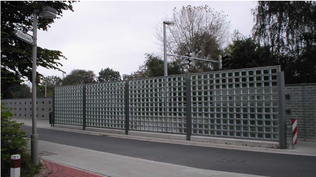
Abbildung 35: Lärmschutzwand in Hannover
