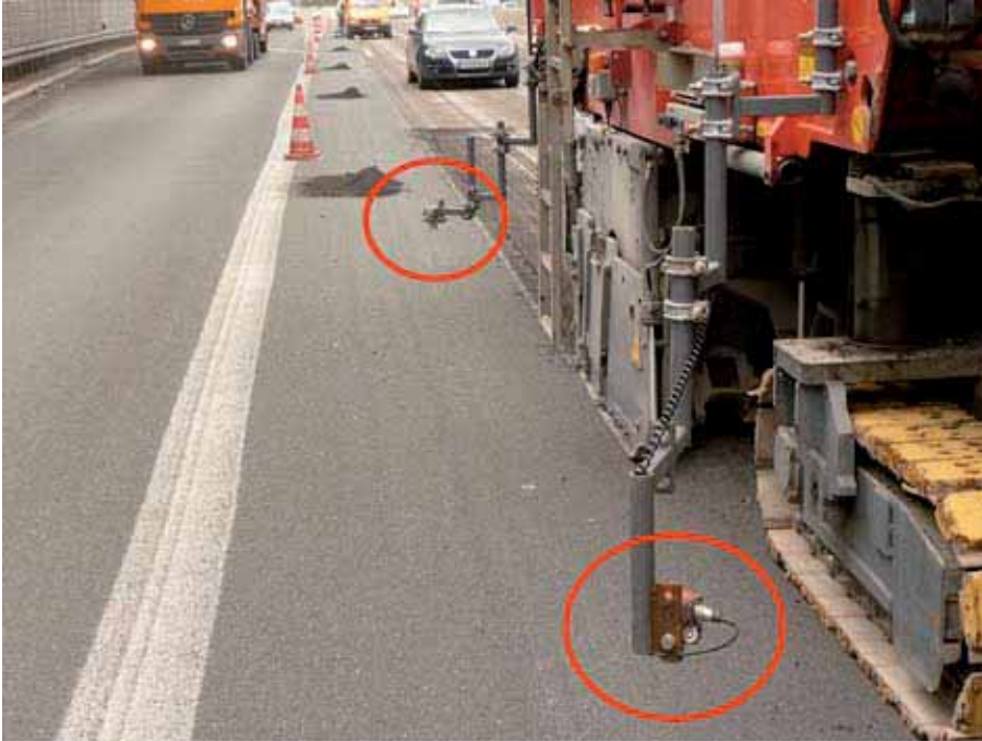
Bild 3: Fräsverfahren mit verbesserter Abtastung der Deckschichtoberfläche
